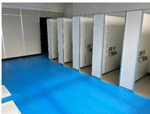
C 科教員室 3 を女子トイレに改修
